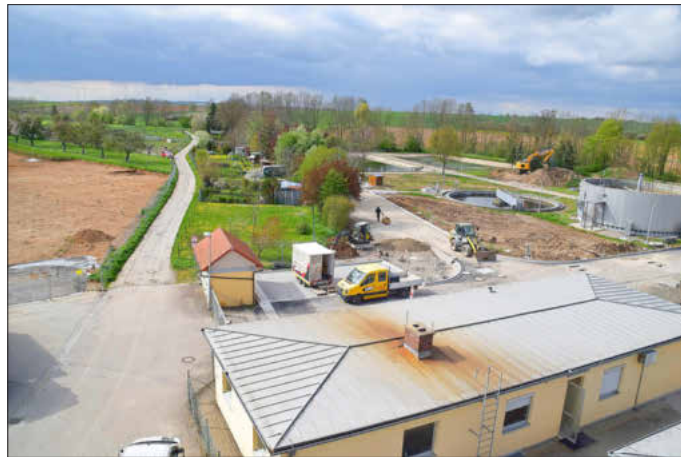
Die Arbeiten für die Erweiterung und Sanierung der Kläranlage sind weitgehend abgeschlossen. Links im Bild entsteht auf dem abgeschobenen Bereich der neue Bauhof.
