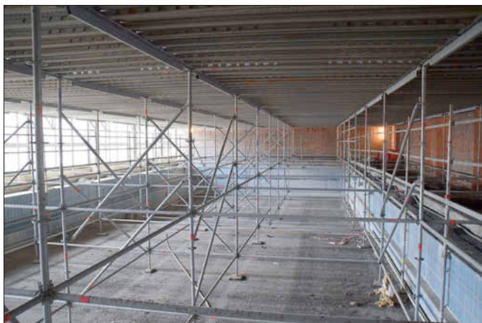
Im Hallenbadbecken steht ein großes Deckengerüst. Das Gebäude ist mittlerweile komplett entkernt, der Beton ist saniert.
