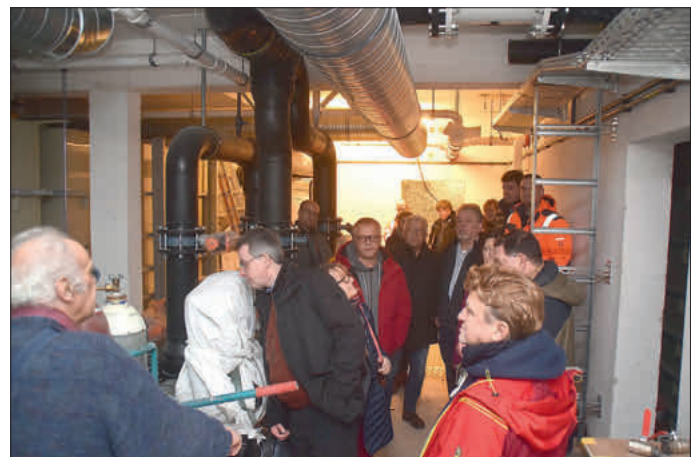
Im Untergeschoss ist die Technik untergebracht. Darüber informierte Johann Franz Wach (links). Über den allgemeinen Baufortschritt gab Holger Heine (rechts) Auskunft.
