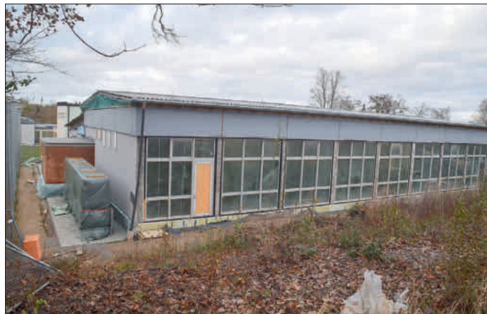
Der Platz hinter dem Schwimmbad wurde für die Technik benötigt.
