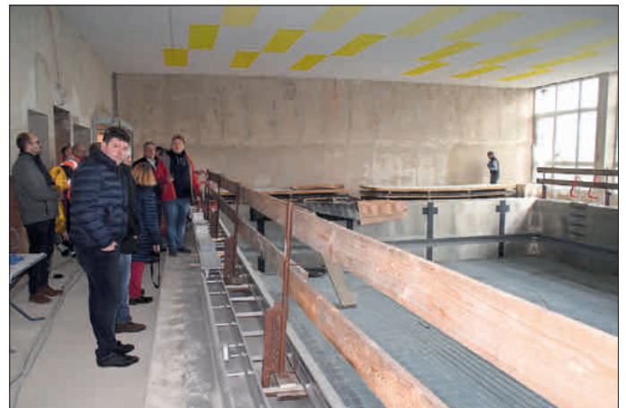
Das Becken im Uffenheimer Hallenbad bekommt seine Edelstahlverkleidung. Fotos: Gerhard Krämer
