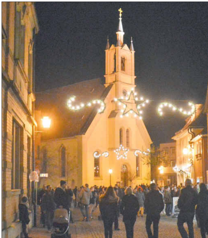
Foto: Spitalkirche Abendlich in der Advents- und Weihnachtszeit angestrahlt, scheint alles in Ordnung mit der Spitalkirche. Doch die Kirche, für die die Hospitalstiftung verantwortlich ist, hat Sanierungsbedarf. Foto: Gerhard Krämer
