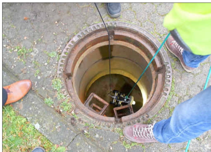
Der Fahrwagen FW 90 L wird in den Kanal abgelassen.
