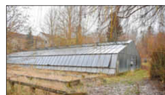
Noch steht auf dem Gelände ein altes Gewächshaus. Dieses soll einem modernen Gesundheitszentrum weichen.
