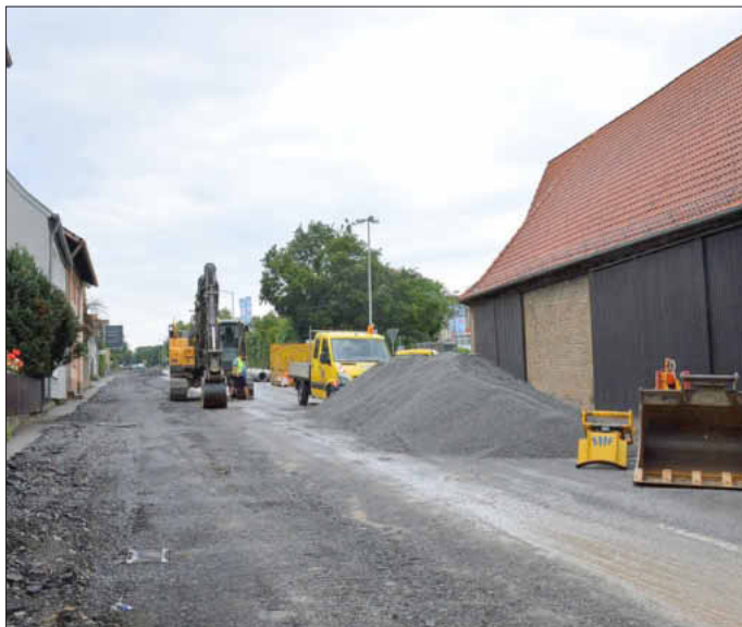
Ein Teilstück der Bundesstraße 13 in Uffenheim wird erneuert. Die Stadt verlegt im Vorfeld neue Kanäle und Leitungen. Derzeit ist die Durchfahrt gesperrt, im September kann man zumindest Richtung Würzburg durchfahren.
