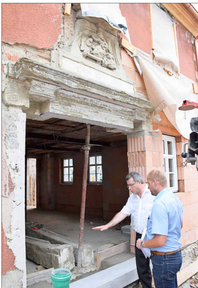
Das alte Eingangsportal befindet sich nun über dem neuen Eingang.
