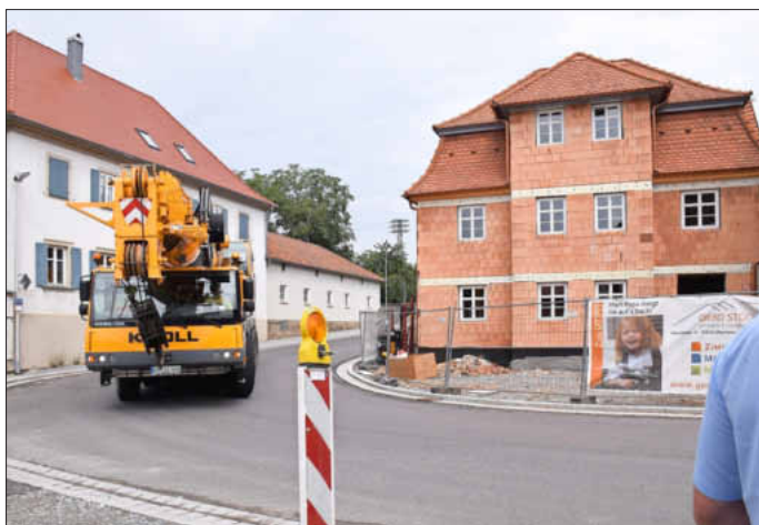
In der Kurve beim Anwesen Ansbacher Straße 26 soll noch eine Markierung angebracht werden, damit die Lkw den Kurvenradius voll ausnutzen.
