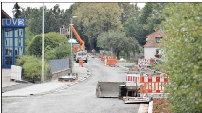
Die Asphalttragschicht ist bei der Custenlohner Straße aufgetragen. Im September kommt die Deckschicht.
