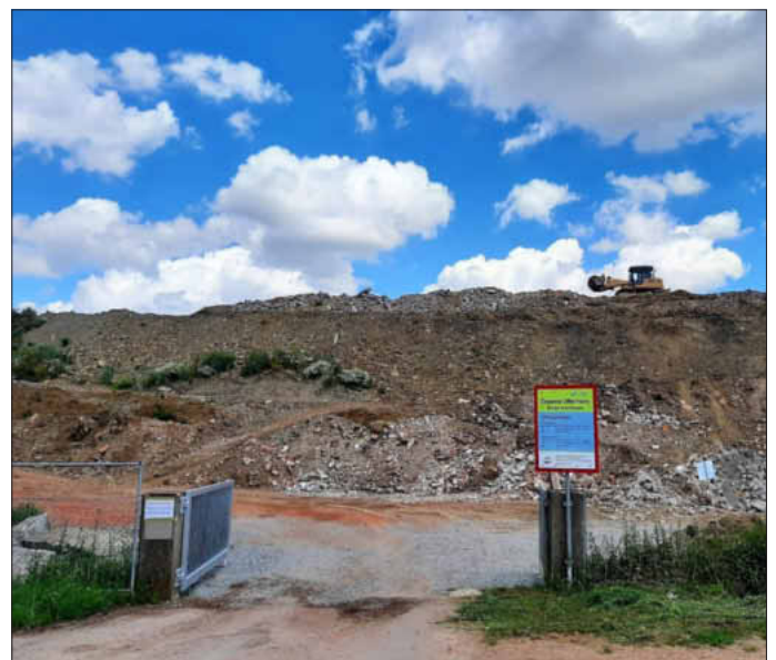
Die Planungen für die Erweiterung der Erdaushub- und Bauschuttdeponie Uffenheim laufen. Gewünscht ist, dass dort auch gipshaltiges Material abgelagert werden kann.
