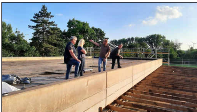
Auf dem Dach geht es bald weiter.
