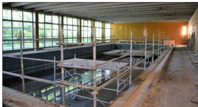
Der Hubboden des Beckens wird noch ausgebaut.
