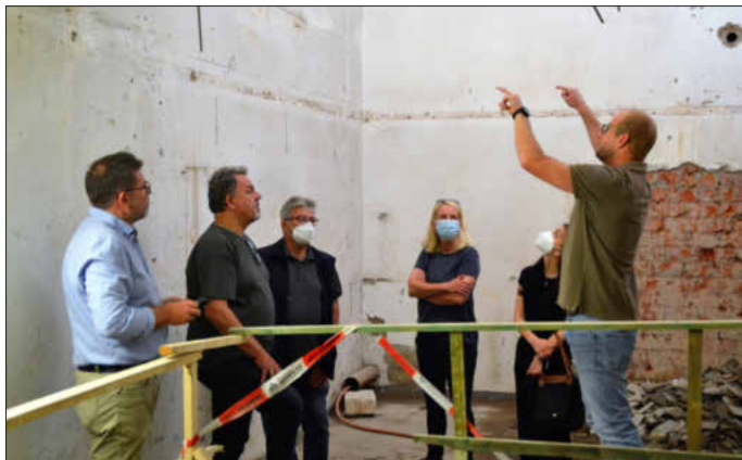
Im Keller des Bades sind die Abbrucharbeiten erledigt.
