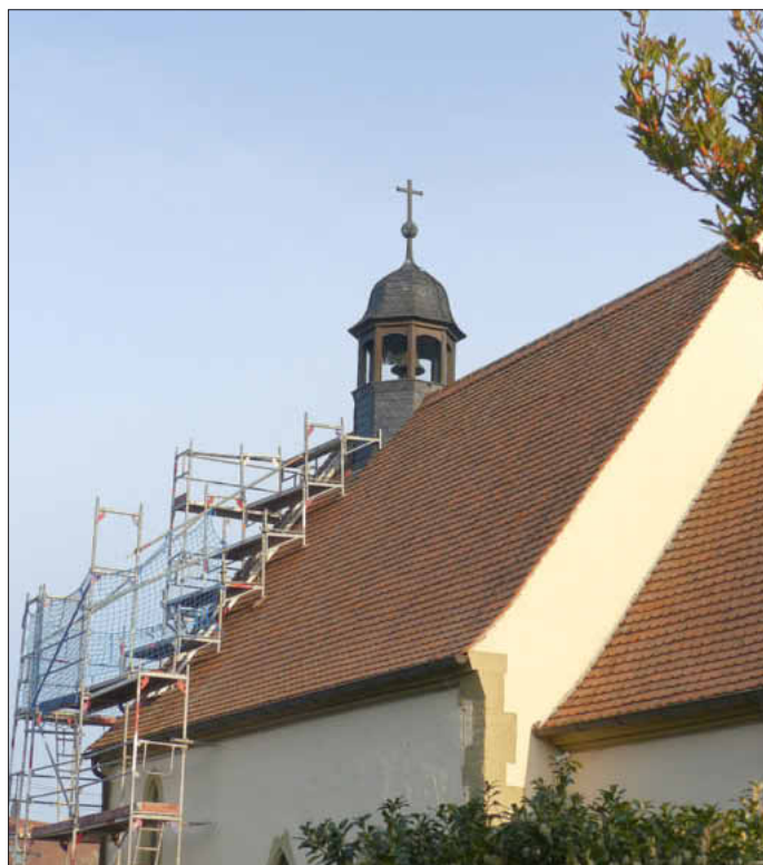
Elektrifizierung der Jobstkapelle
