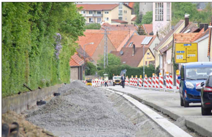
Links wird der Geh- und Radweg gebaut.
