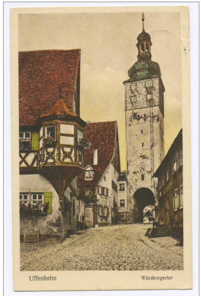
Das Bild zeigt die Würzburger Straße von der Alten Post aus gesehen mit Blick auf das Würzburger Tor, links davor der Fachwerkbau des Scherenhofes mit dem markanten Erker und anschließend das sog. Wolf-Haus.
