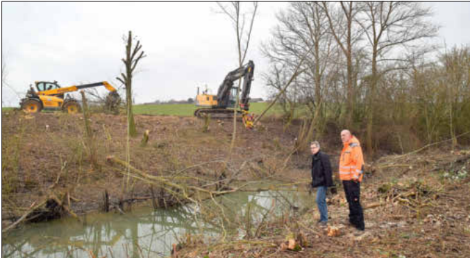
Bürgermeister Wolfgang Lampe (links) und Bauhofleiter Thomas Siebert überzeugen sich vor Ort von den Arbeiten an den Regenrückhaltebecken. Fotos: Gerhard Krämer
